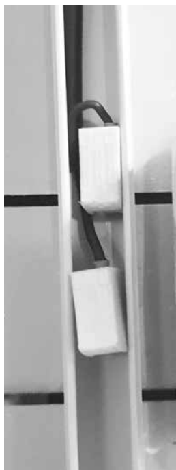
Collegamento nella canalina per cavi
